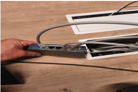
Instalación Switch en caja artefactos
